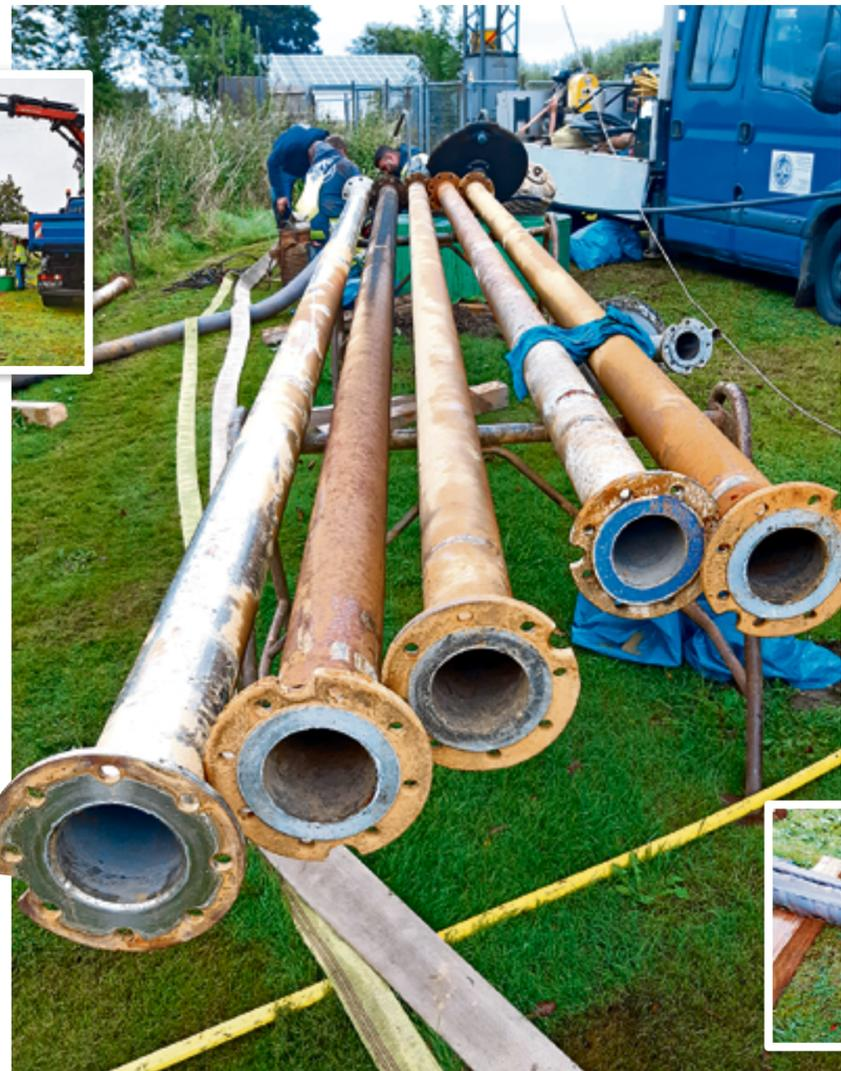
band jedoch Glück im Unglück. „Eine Inspektion per Kamera zeigte, dass der Brunnen schacht unversehrt geblieben war.“ Andernfalls wären zusätzliche Bauarbeiten nötig gewesen. Nun blieb es bei der Reinigung des Schachtes und dem Wiedereinbau der Pumpe. „Die Steigleitung haben wir aus Edelstahl erneuert, damit nun alle Materialien besser zusammenpassen und sich nicht negativ beeinflussen.“
