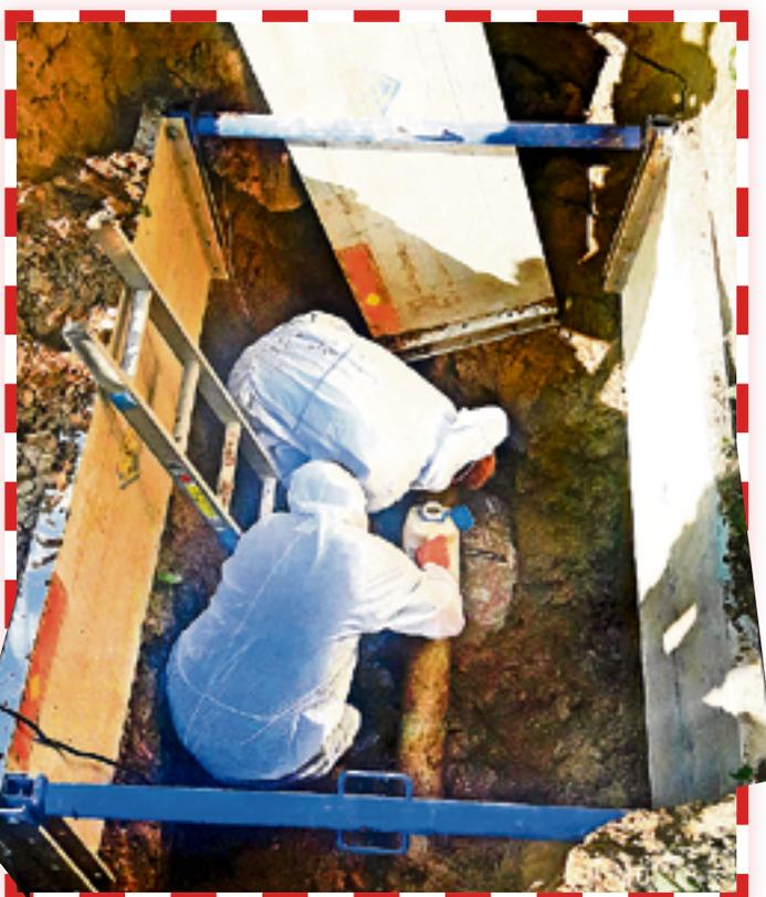
**Großer Schaden – schnelle Hilfe. Während der Arbeiten zum Glasfaserausbau kam es in der Westerholzer Haffstraße zum Rohrbruch einer Trinkwasserhauptleitung. Die Mitarbeiter des WV Nordangeln waren im Einsatz.**
