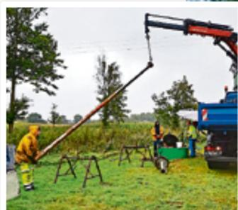
Im August erfolgten die Arbeiten in Schnarup-Thumby. „Wir mussten die Pumpe ziehen, um zu sehen, was der tatsächliche Grund für die verminderte Pumpenleistung war“, erklärt Vorstandsvorsteher Volker Ohlsen. Gut 35 Meter unter der Erde befindet sie sich, kein leichtes Unterfangen also. „Wir brauchten dafür einen LKW mit Kran, der die sechs Einzelteile der Steigleitung heraus hob. Jedes Element war wiederum sechs Meter lang“, beschreibt er den Aufwand. Dieser lohnte sich jedoch.
