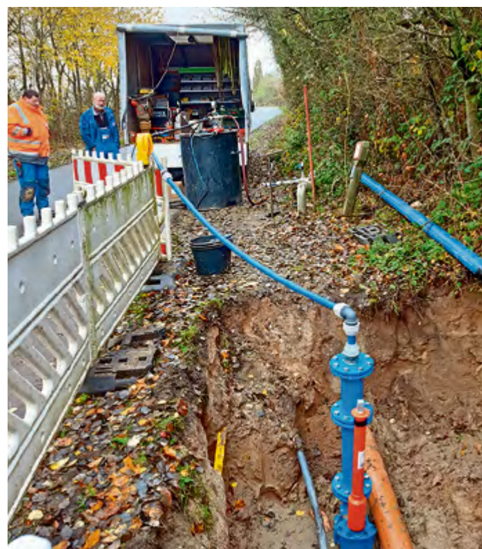
Vor der Inbetriebnahme wurden Druck und Dichtigkeit der neuen Leitung geprüft.
