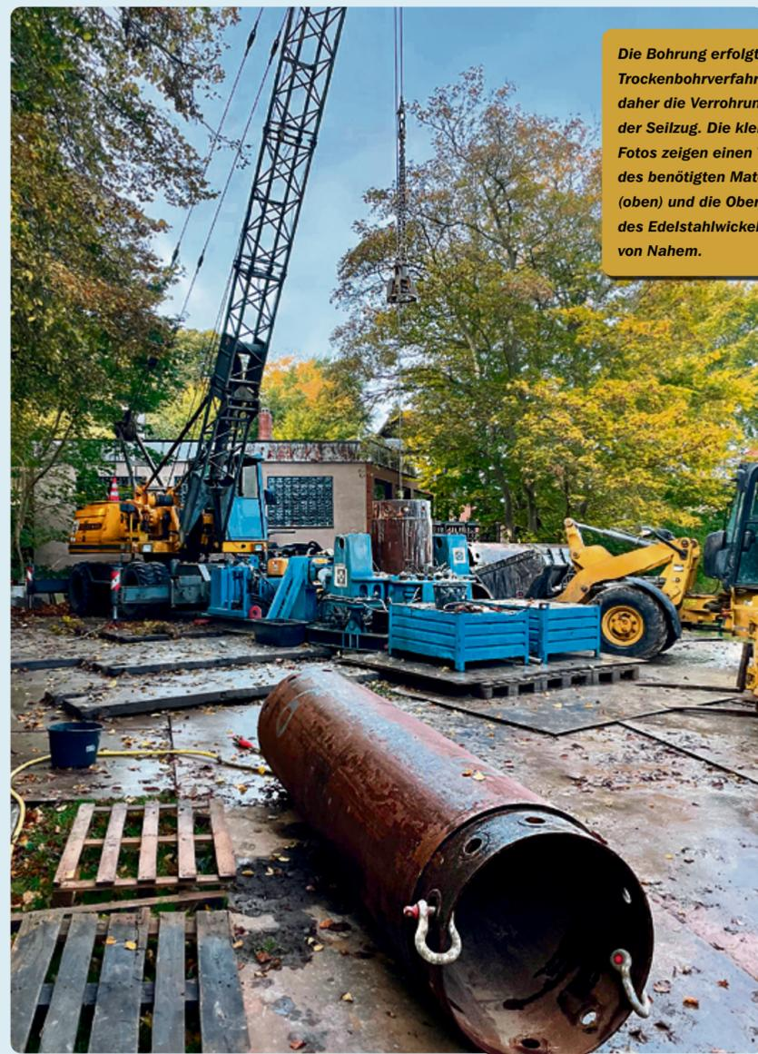
Die Bohrung erfolgt im Trockenbohrverfahren, daher die Verrohrung und der Seilzug. Die kleinen Fotos zeigen einen Teil des benötigten Materials (oben) und die Oberfläche des Edelstahlwickelfilters von Nahem.
