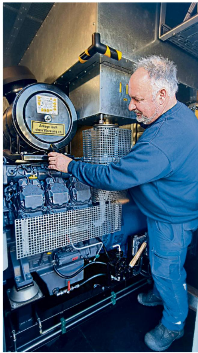
Thomas Tramsen an der Ersatzstromanlage des WV Nordangeln. Sollte die Energielieferung tatsächlich einmal stoppen, springt sie automatisch ein, um den Betrieb aufrechtzuerhalten. Foto: WV
