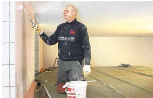
Hier nimmt Bernd Ackermann von der ausführenden Fachfirma aus Rendsburg die letzten Pinselstriche vor. Damit ist die Betonsanierung an Decke und Wänden in diesem Raum im Wasserwerk Glücksburg nahezu abgeschlossen. Während der Arbeiten wurde die normalerweise nach oben offene Filteranlage sorgsam geschützt. Foto: SPREE-PR/Galda
