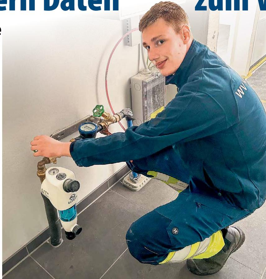
Azubi Niklas Jensen an der Zählerarmatur, die beim WV Nordangeln ein digitales Messgerät mit Funkmodul enthält.
